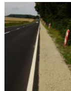
Wiederherstellung der Bankette mit dem Bankettfertiger.
