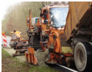
Wiederherstellung der Bankette mit dem Bankettfertiger.
