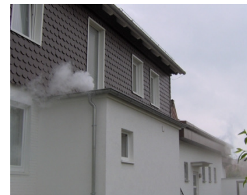
Fehlanschluss Fallrohr
